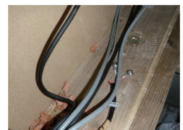
壁内土台測定
